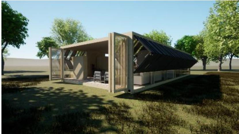
**Abbildung 6: Außenansicht des Einfamilienhauses mit innovativen klappbaren Fassadensystem**
