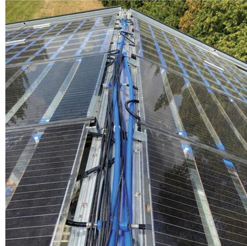
**Abb. 20: Aufnahmen aus der Fertigung der PVT-Module (oben links) und der Montage entsprechend des Medine- und Verlegeplans, unten rechts: elektrische und thermische Medienführung im Firstbereich**
