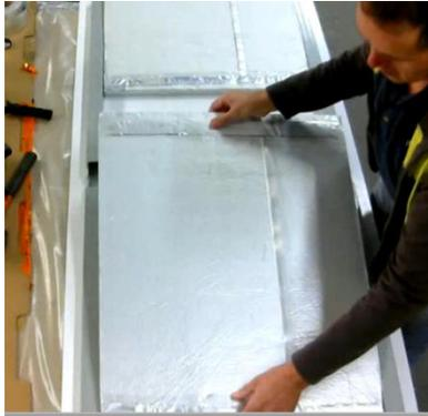
Einbringen der VIP in die GFK-Unterkonstruktion
