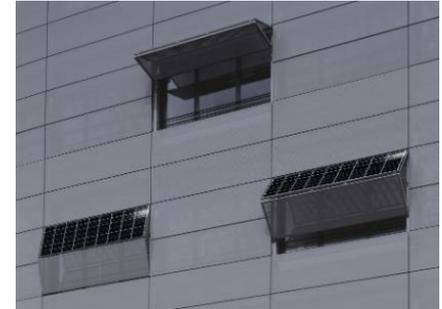
Falt-Hebeläden mit PV
