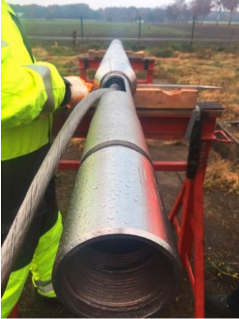
Abb. 10: Vorbereitung der MDA-Installation
