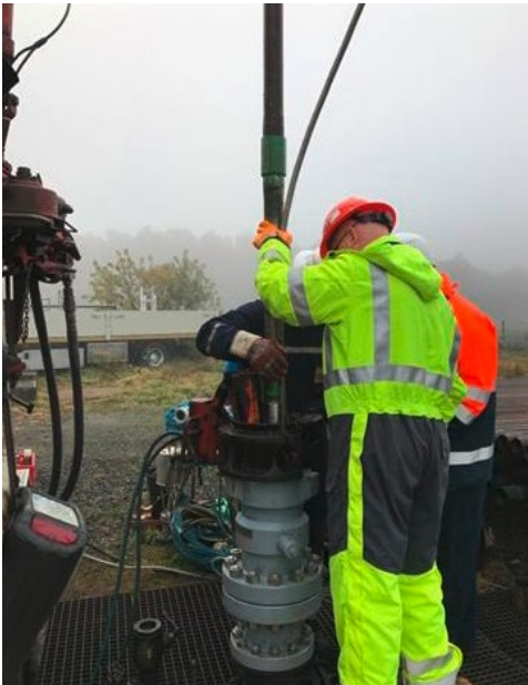
Abb. 11: Installation des MDA
