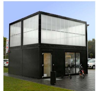
Smarte modulare Leichtbaugebäude mit hohem Vorfertigungsgrad, hoher Energieeffizienz und hohem Nutzerkomfort
